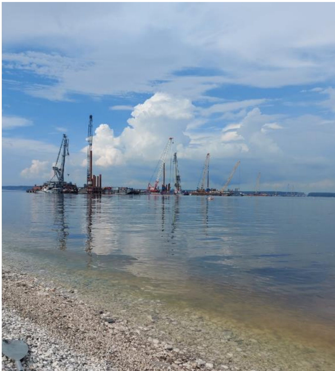
Строительство моста под Климовкой
