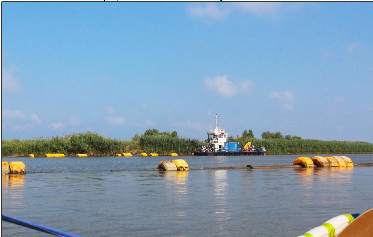
Фото 19 – Суда, проводящие углубление канала
