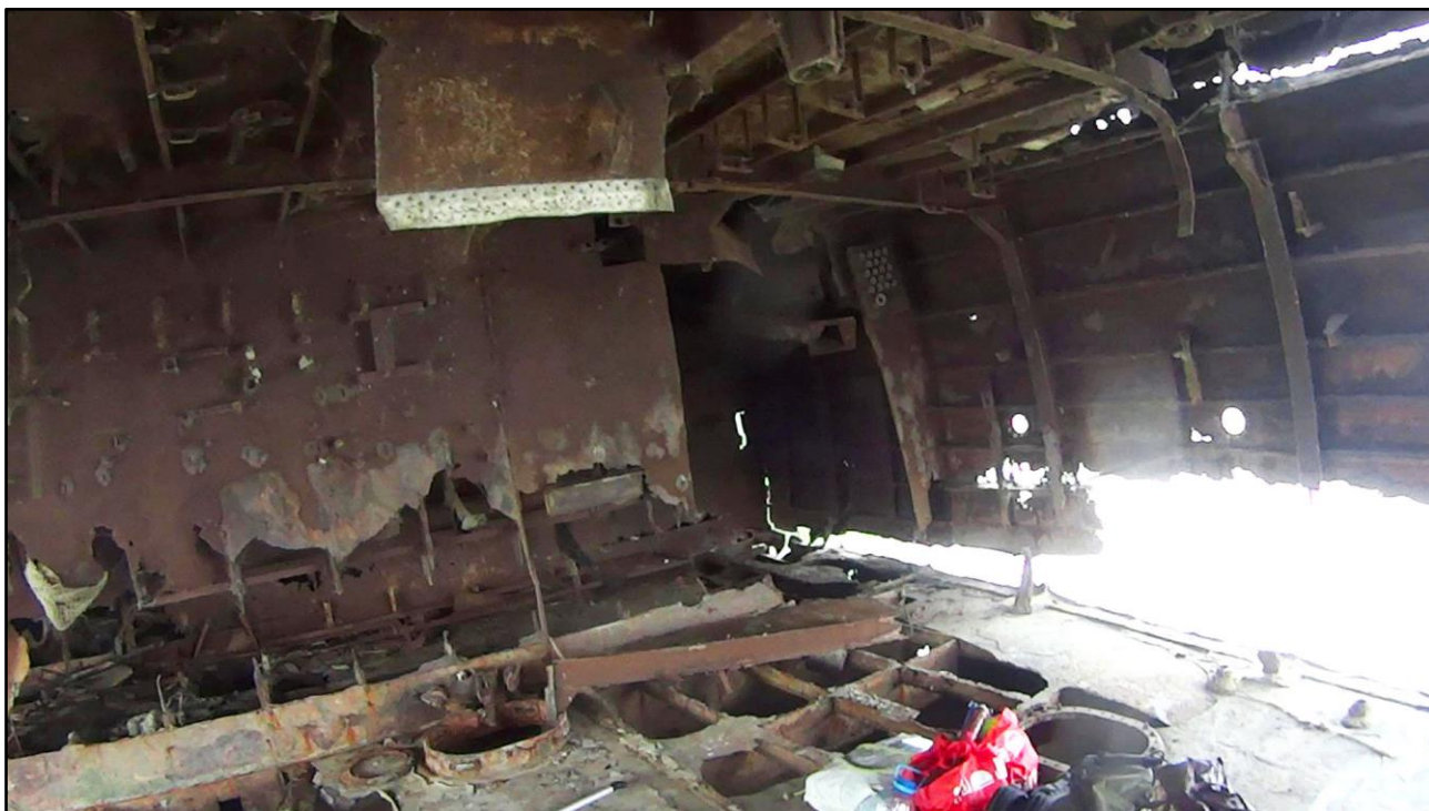
Фото 35 – Состояние судна изнутри
