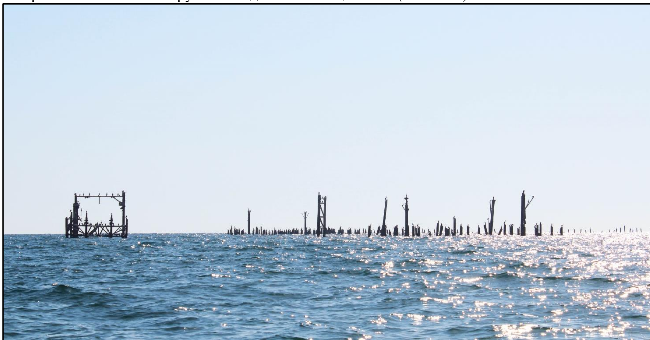
Фото 67 – Останки металлических конструкций в воде
