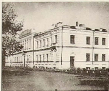
Здание пединститута. Фото 1932 г.
