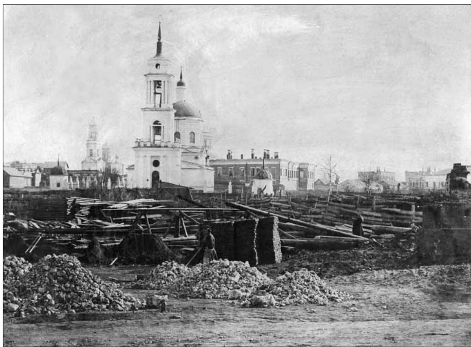
Троицкая церковь в руинах после пожара 1864 г. УКМ
