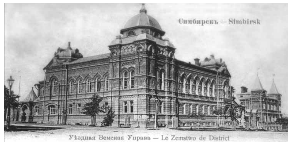
Здание Симбирской уездной земской управы (ныне Гарнизонный дом офицеров)
