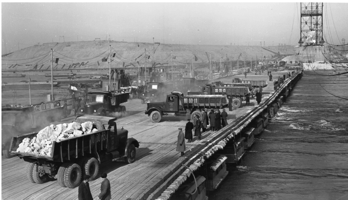
Илл. 2. Перекрытие Волги на строительстве Куйбышевского гидроузла (отсыпка горной массы с наплавного моста), конец октября 1955 г. (из фондов Тольяттинского краеведческого музея).
