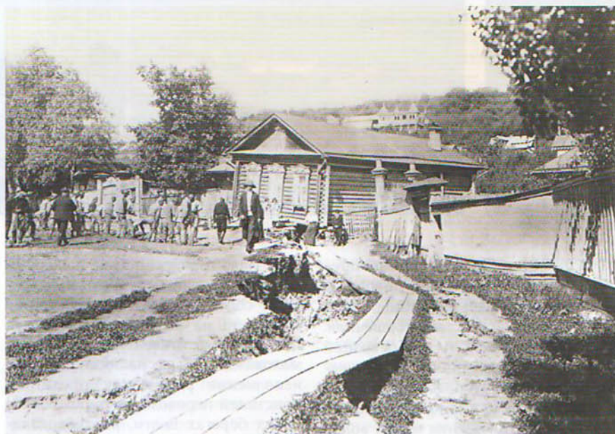
Оползень. Петропавловская дорога
