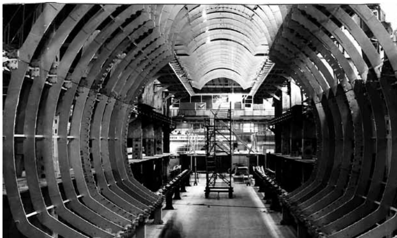
Постройка стапеля фюзеляжа на Киевском авиационном производственном объединении (КиАПО), г. Киев, 1977 г.
