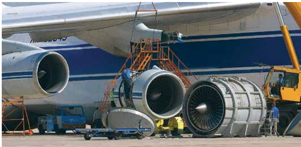
Замена двигателя на Ан-124-100.
