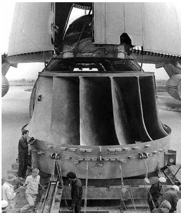
Чугуевская «шапка Мономаха». Вес турбины для ТашКумырской ГЭС составлял 90 тонн, что уже сопоставимо с собственным весом самолета. Требуются филигранные технологии.
