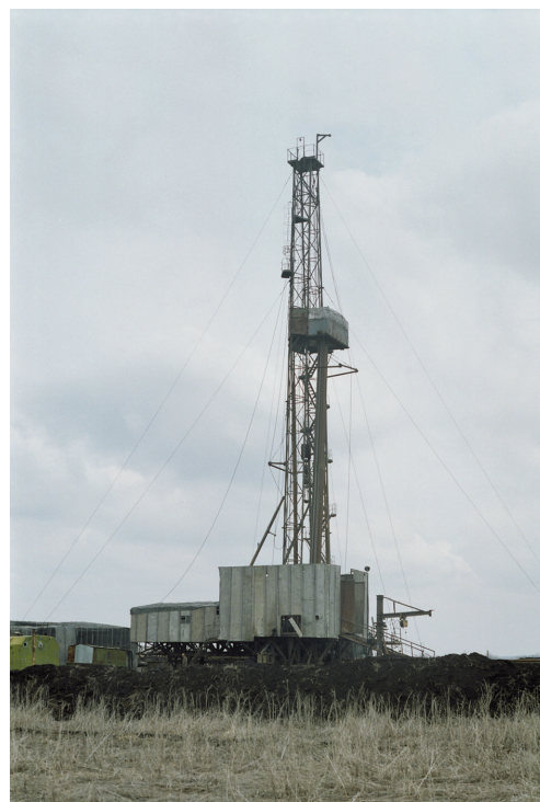
Монтаж агрегата А-50-У для ремонта нефтяной скважины
