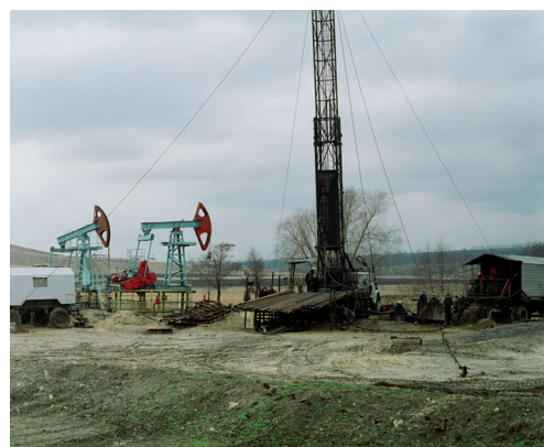
Ремонтные работы на нефтяной скважине. Ульяновская область, Новоспасский район
