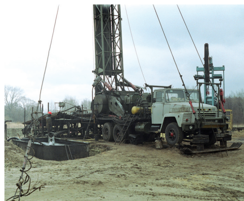
Монтаж агрегата А-50-У для ремонта нефтяной скважины
