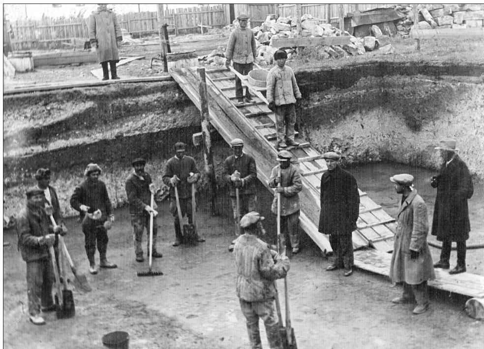
Окончание бетонирования железобетонной плиты в основании будущего памятника В. И. Ленину. Источ.: Фонды ФГБУК «Государственный историко-мемориальный музей-заповедник «Родина В. И. Ленина»
