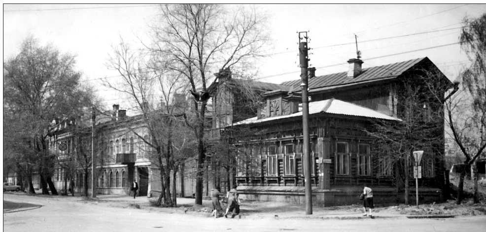
Бывшая усадьба мясан Банцековых (деревянный дом с пристроем и мезонином снесён).
