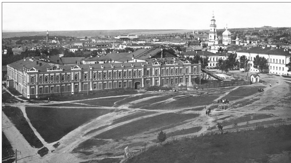
Вид с водопроводной башни на Соборную площадь и здание Троицкой гостиницы. Источ.: ГАНИ УО. Ф. 57а (Центр документации новейшей истории Ульяновской области. 1944 г. – по настоящее время). Оп. 2. Д. 65. Л. 125
