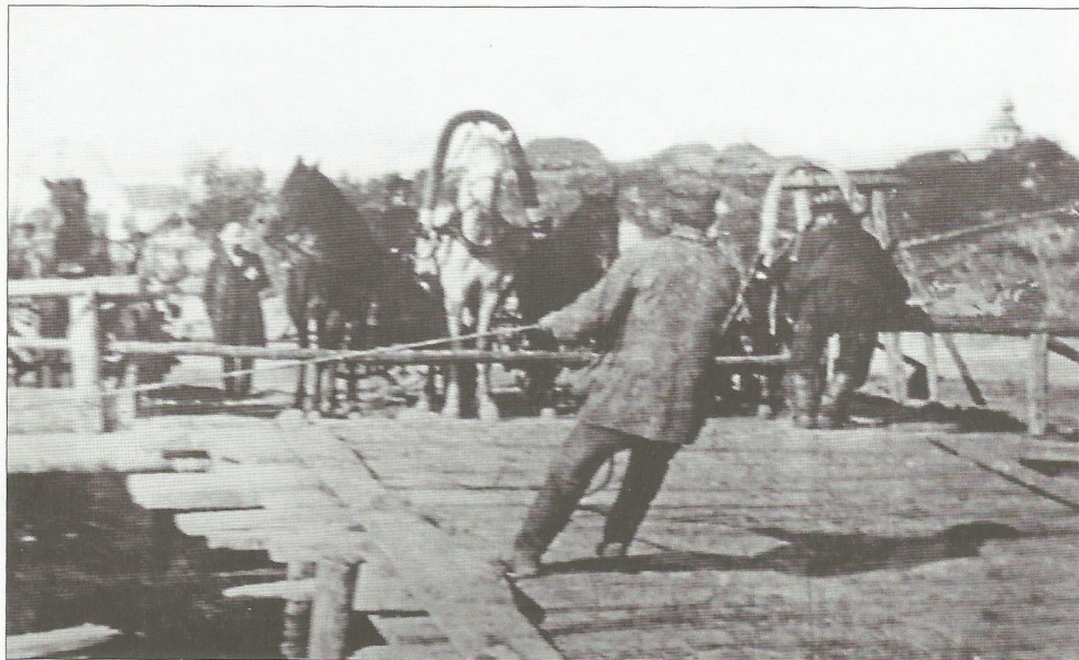
Паромная переправа через Суру
