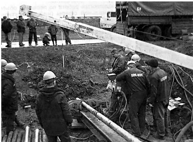
Рабочие ООО «ВИС-МОС» ведут прокол газовода через железную дорогу в северную часть р.п. Майна. Октябрь 2002г.
